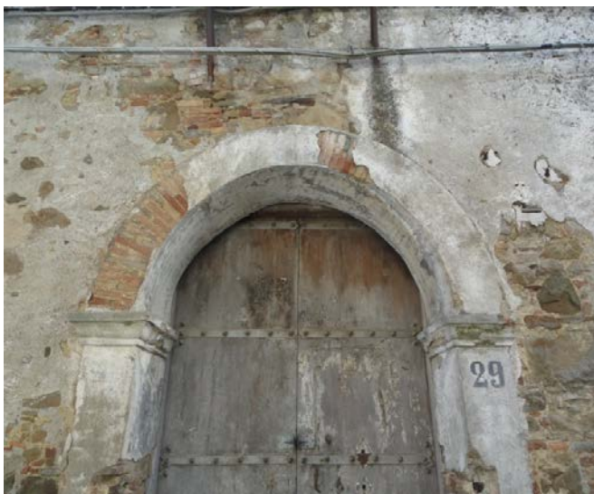
Ingresso principale del Palazzo da ristrutturare
